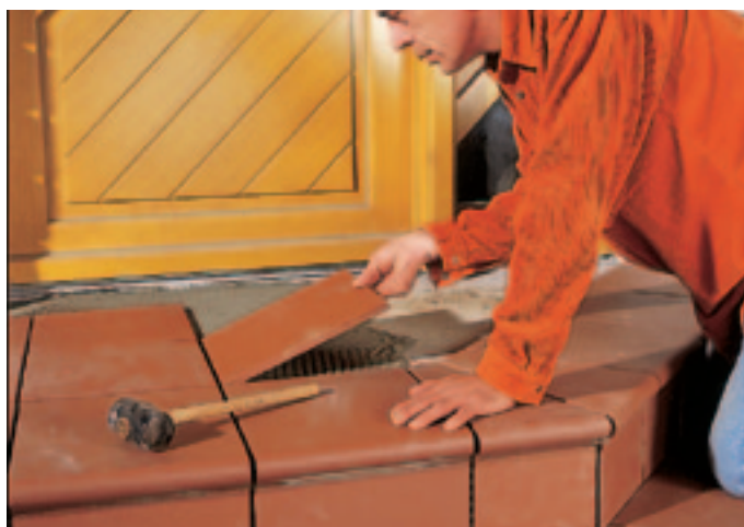
4. FX 900 – укладка плитки
