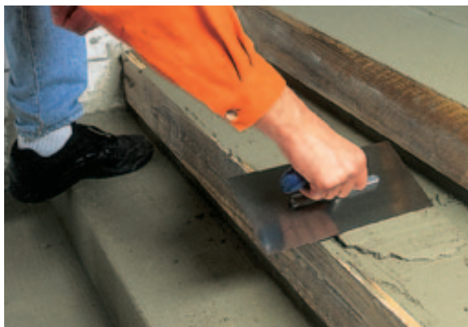
2. BRS – ремонт основания
